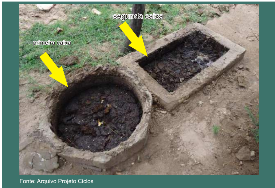
Figura 9 - Caixas de saída após instalação do biodigestor
