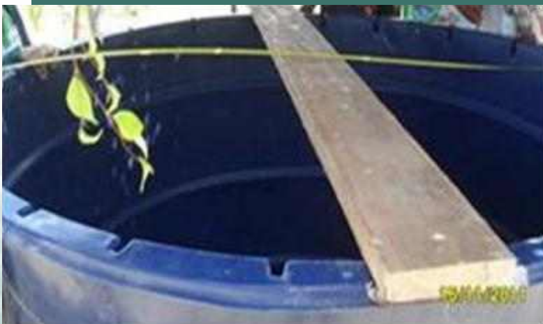
Figura 16 - Fixação da madeira na caixa d'água
