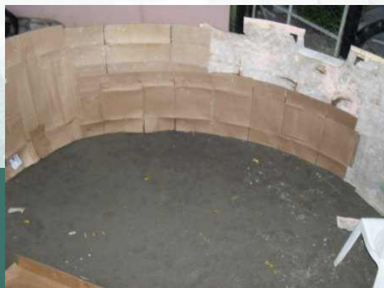
Figura 27 - Preenchimento da câmara digestora
