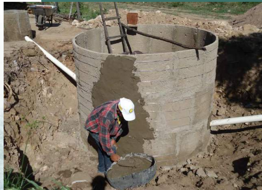
Figura 7 - Amarração da câmara de biodigestão
