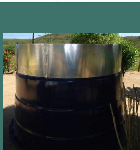
Figura 20 - Caixa d'água com o anel de zinco
