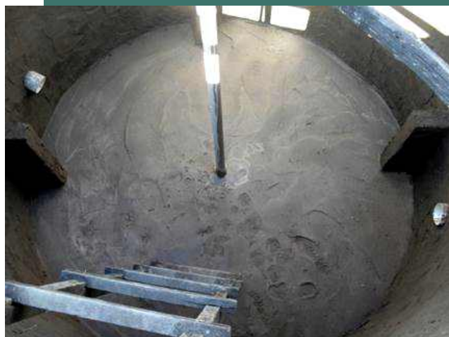
Figura 13 - Interior da câmara de biodigestão (sentido entrada/saída)
