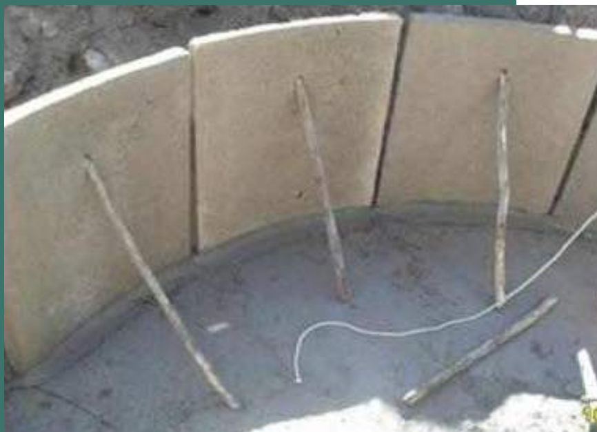
Figura 6 - Posicionamento das placas para a construção da câmara de
