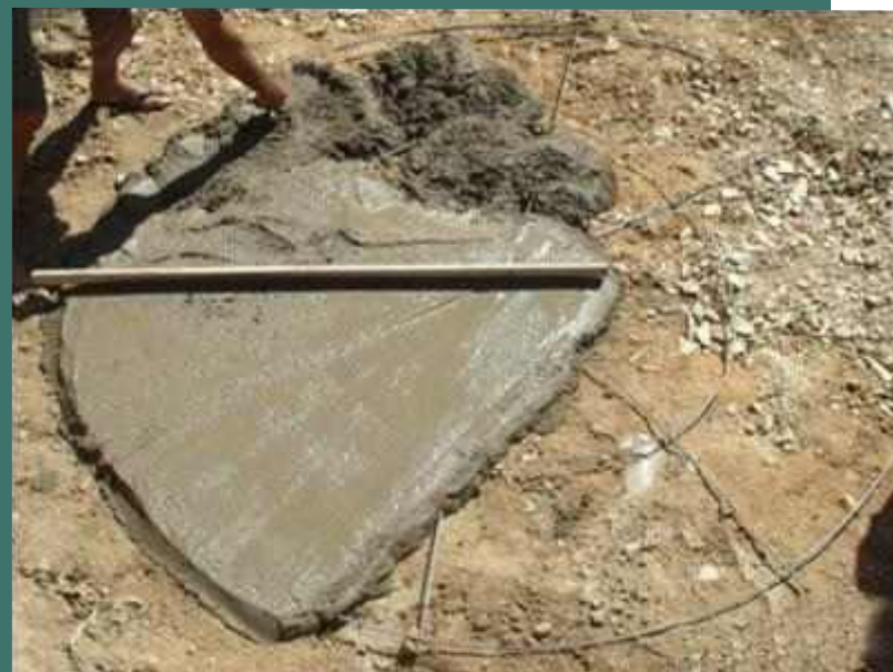
Figura 5 - Construção do piso da câmara de digestão
