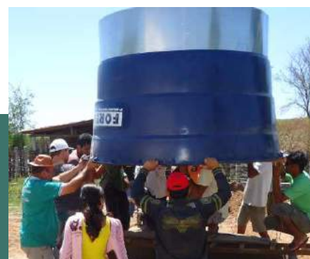
Figura 22 - Processo de encaixe da câmara biodigestora
